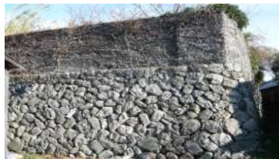
西浦地区 防風石積み塀
